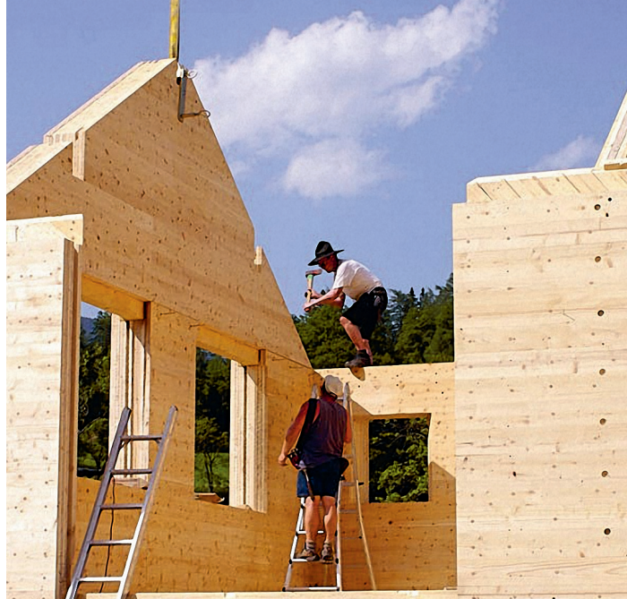
Ein Holzhaus in Konstruktion
